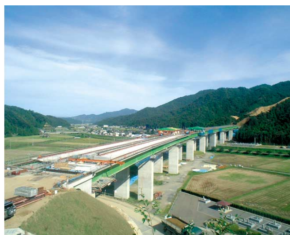
第 1 図 「佐分利川橋」施工時全景 Fig. 1 “Saburigawa Bridge”
