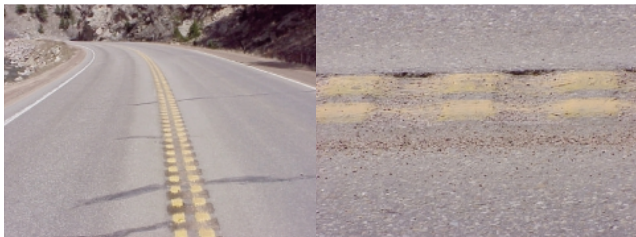
写真-4 コロラド州におけるセンターラインに敷設されたランブルストリップ (State Highway119)
