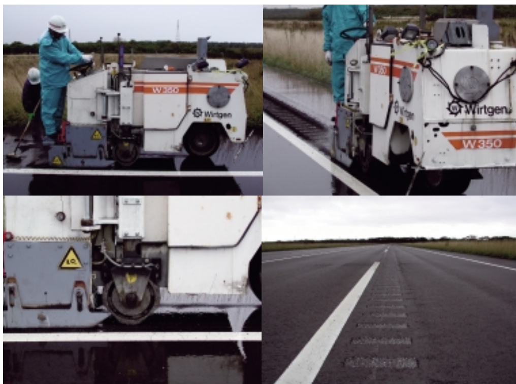
写真 - 5 苫小牧寒地試験道路における試験施工状況
