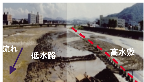
写真-2 豊平川・低水路の土砂堆積状況(2)
