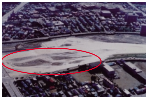
写真-1 豊平川・低水路の土砂堆積状況(1)
