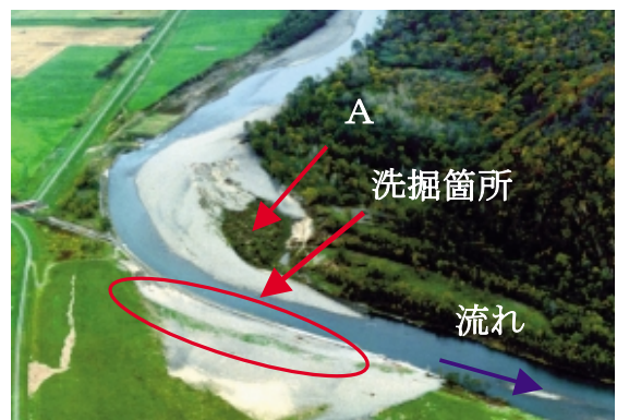
写真－4 渚滑川・高水敷の洗掘状況(2)
