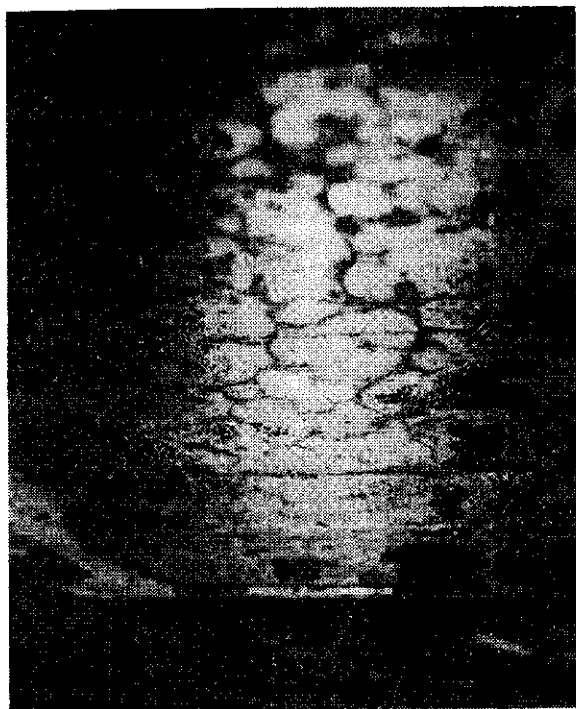
写真—1 床版下面のクラック状況
