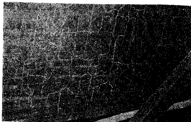
写真—5 損 傷 ラ ン ク 4
