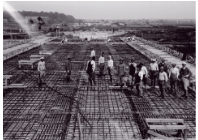
写真 - 6 床版の鉄筋組立状況
