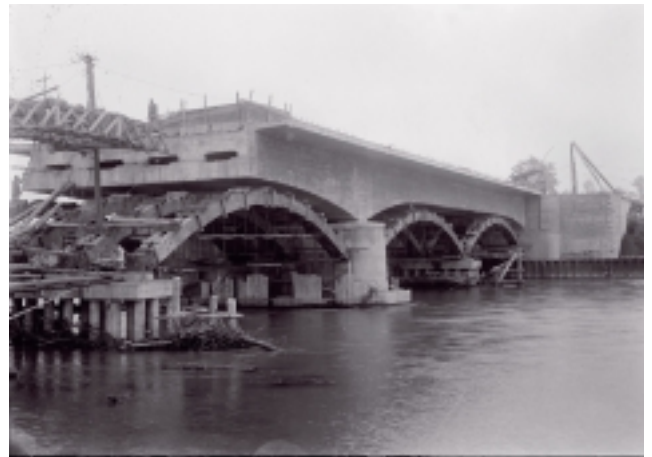
写真-11 コンクリート打設後のアーチ式支保工
