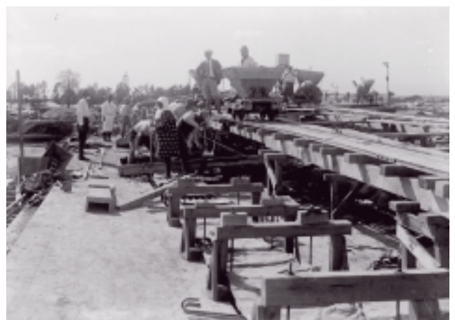
写真-4 コンクリート打設状況（その2）
