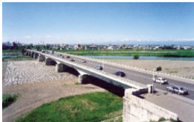
写真 - 1 供用中の初代十勝大橋
