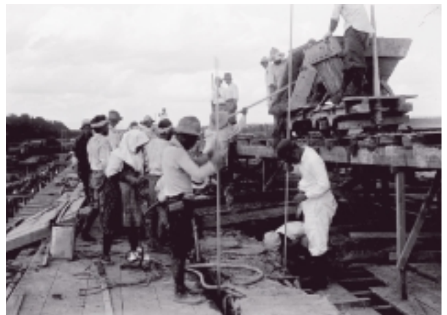
写真-3 コンクリート打設状況（その1）
