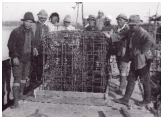
写真 - 8 ロッカー支承の鉄筋組立状況
