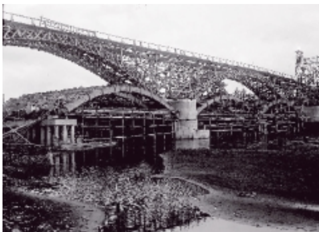
写真-10 アーチ式支保工組立状況(その2) (支保工の上側の木造構造物は資材運搬用仮橋)
