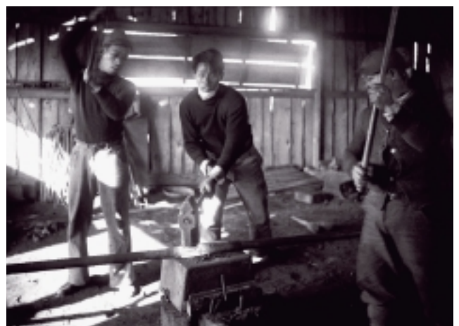
写真 - 7 継手の槌打ち状況
