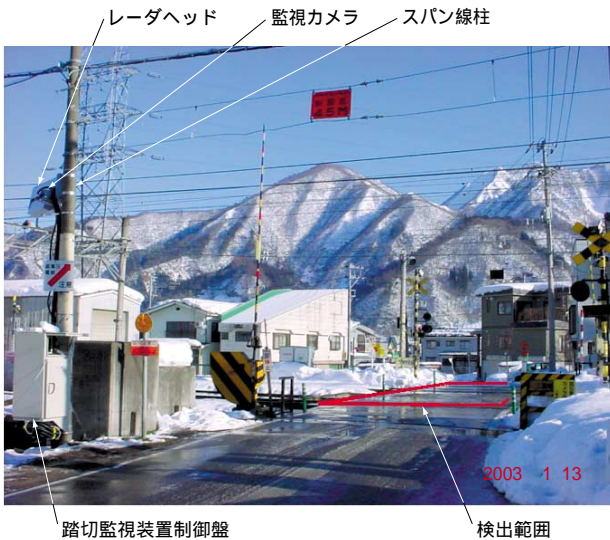
第 7 図 三次元レーザレーダ設置状況と検出範囲 Fig. 7 Setup of 3D laser radar and detection area
