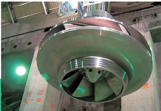
小丸川発電所ポンプ水車ランナの据付け
