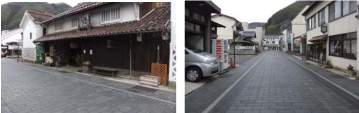
写真-参. 7 御影石の乾式工法により整備された街路
