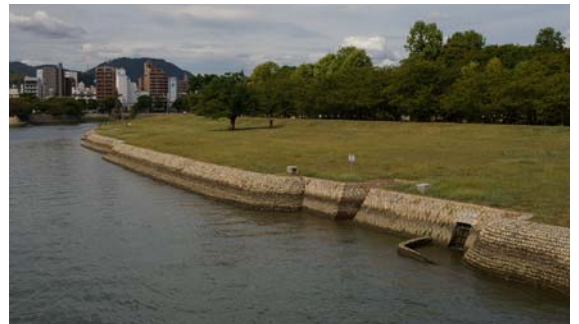
写真-参.16 基町護岸(空鞆橋の上流区間)
