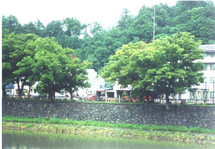
写真-2.23 横手川の河川改修で残された樹木（右）と保護工法（左）
