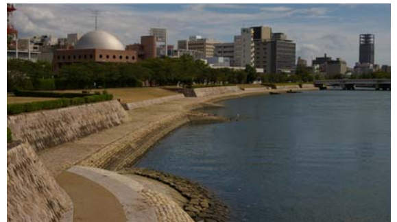
写真-参.17 基町護岸(空鞆橋の下流区間)
