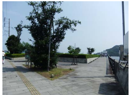
写真-参. 31 整備後の状況
