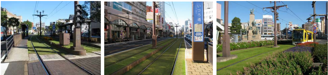
写真-参. 32 整備後の状況
