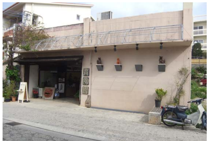
写真-3.11 街路舗装と一体となった店舗入口部分の舗装や植栽、ファサード等の修景
