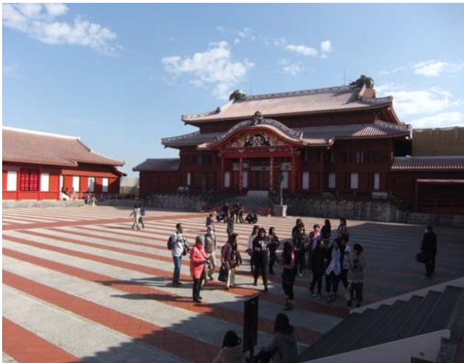
写真-2.24 首里城公園の復元整備
