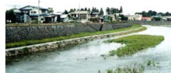
写真-参. 27 護岸の漸次的変化
