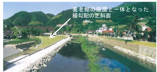
写真-参. 22 整備後の状況
