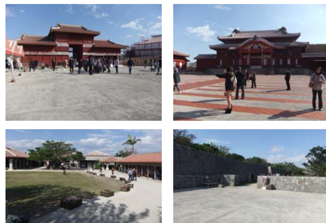
写真-参. 29 復元整備後の状況
