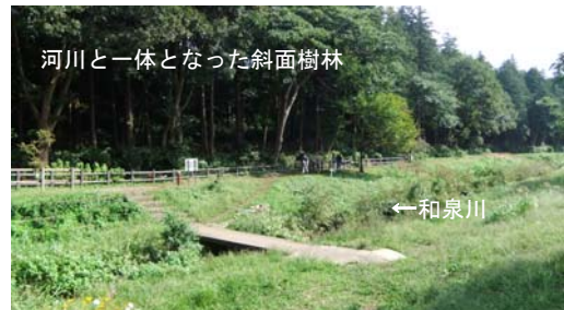
写真-参. 23 整備後の状況
