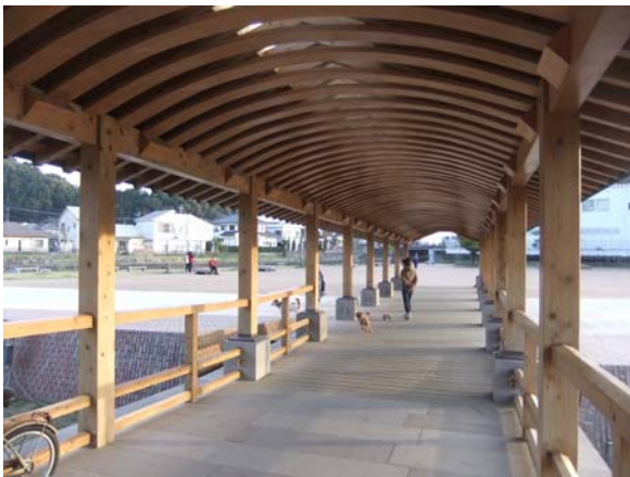
写真-2.15 地場材の飫肥杉を用い伝統的木橋工法で整備された夢見橋
